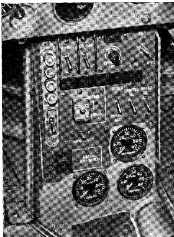
Рис. 57. Средний пульт передней кабины
